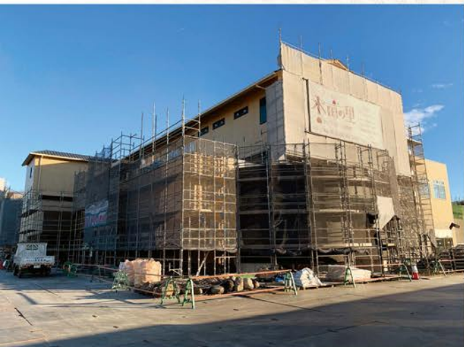
建設工事の様子
